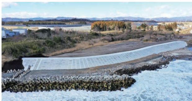
令和6年3月竣工時
