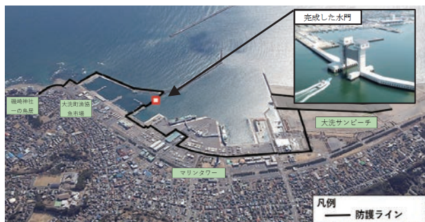
完成した水門と防護ライン
