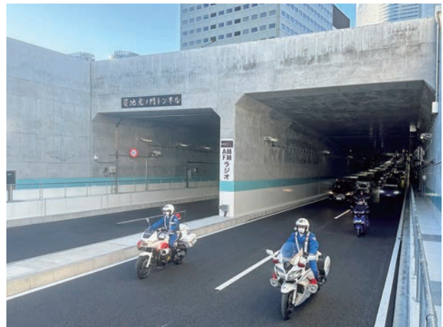
環状第2号線(築地・新橋間)交通開放(令和4年12月18日)
