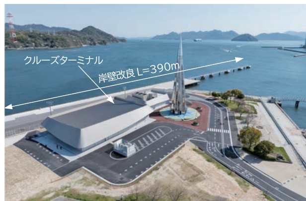
広島港クルーズターミナル全景
