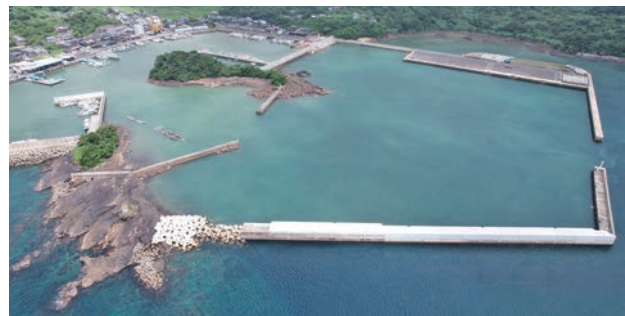
復旧工事完了後
