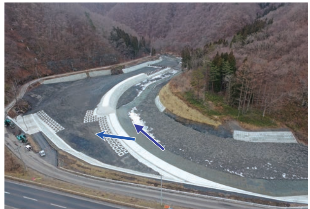
流木捕捉施設全景
