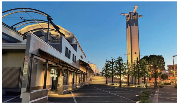
改修後の前庭夕景（照明はすべてLED器具に更新した）
