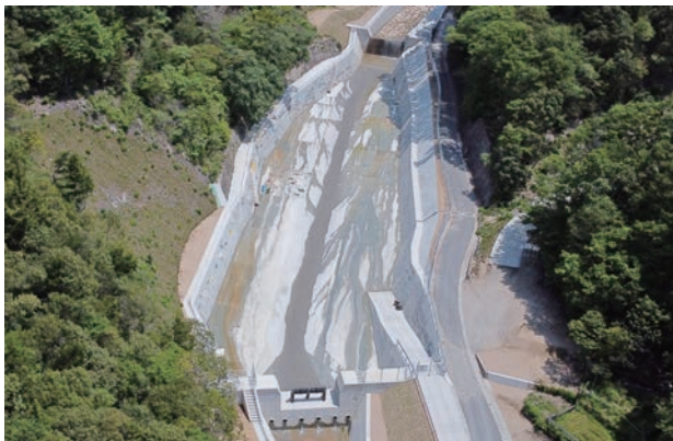
堆積工を下流から上流に向け撮影
