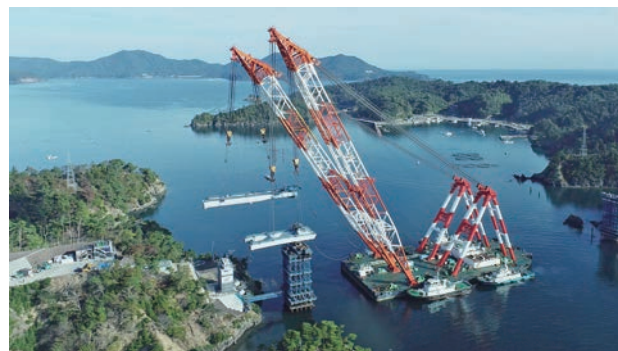
側径間の2ブロック同時架設
