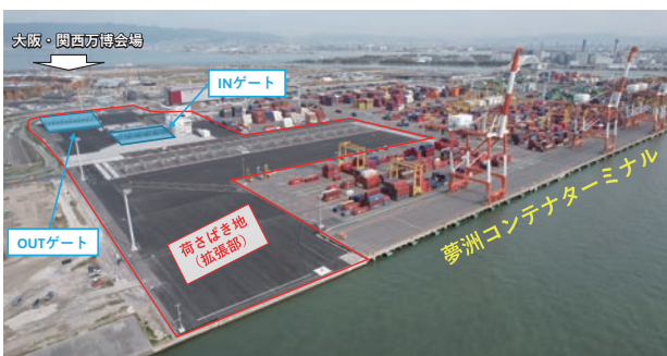
夢洲コンテナターミナル
