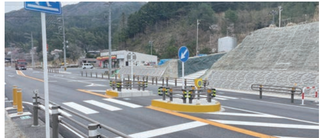
二段階横断施設 整備状況
