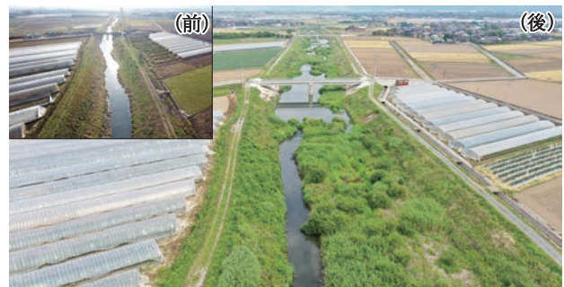
改修前後の桂川の様子
