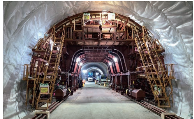
セントル覆工打設状況
