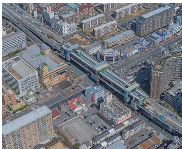
架替え中／橋梁撤去（令和5年3月）
