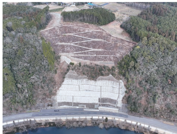
復旧工事完了
