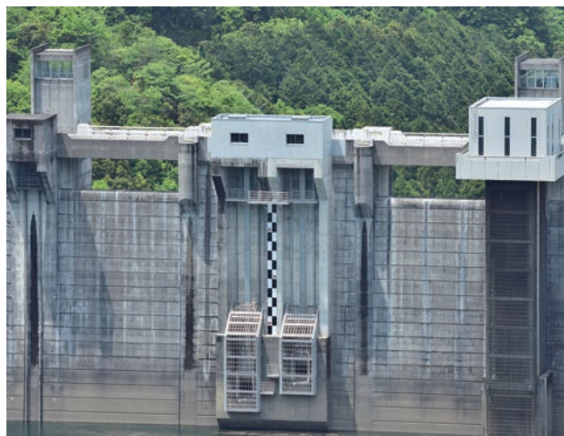
オリフィスゲート全景（完成後）
