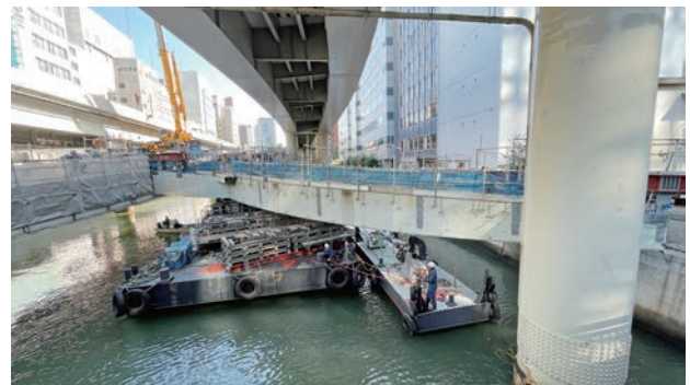
潮位の変動を利用した桁撤去
