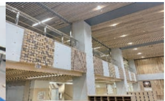
木製パネル設置状況
