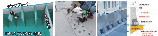
(b) 高耐久性鋼床版 (c) 皿型高力ボルト (d) PCa壁高欄
