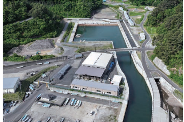
完成した掘込式漁港
