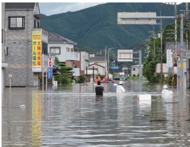
国道56号冠水状況（高知県宿毛市）
