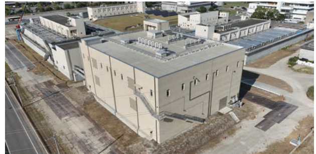
オゾンAOP施設 外観
