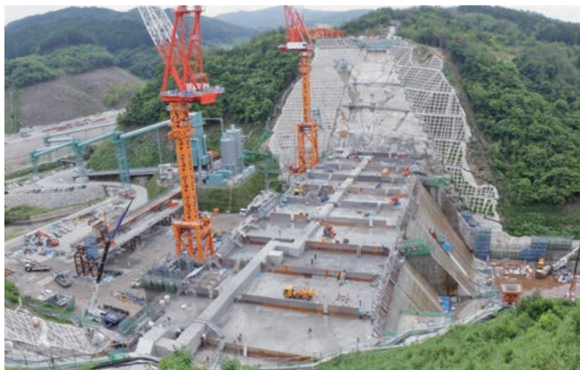
ダム本体の施工（中段プレキャスト監査廊の設置）
