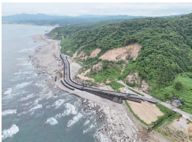
崩壊地を避け、隆起した岩礁の上に造られた緊急復旧道路
